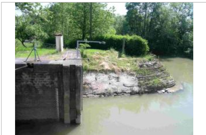
échelle sur le mur de l'écluse
