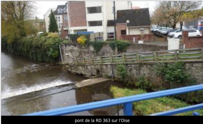
pont de la RD 363 sur l'Oise
