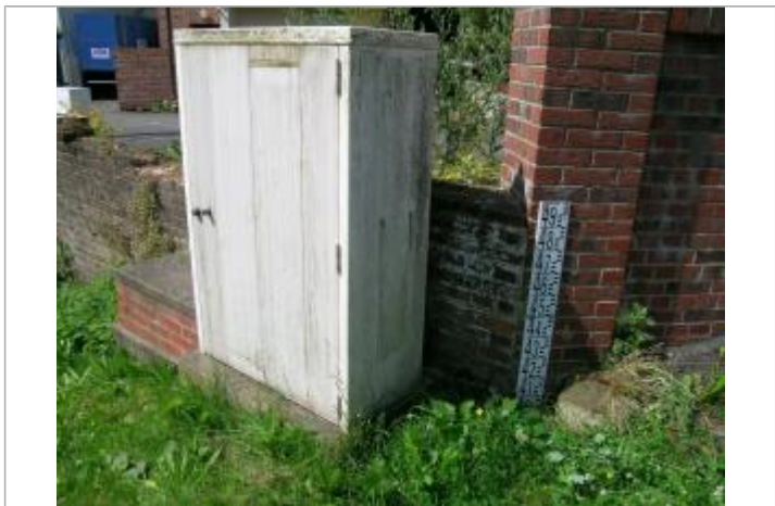
échelle de crue d'Hirson
