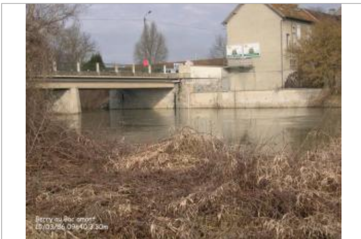
pont de la RN 44 sur l'Aisne
