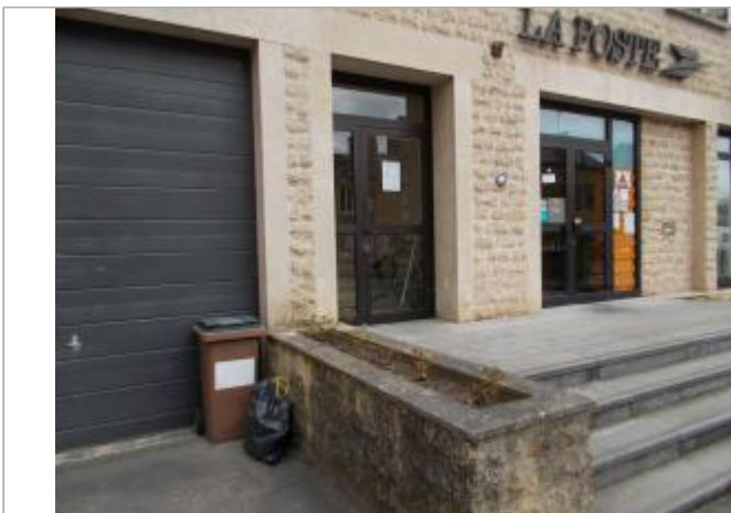
Vue d'ensemble du repère sur la façade du bâtiment La Poste
