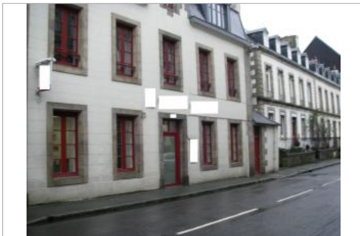
Batiment, 47 rue de Brest - Photographie DHE 2015
