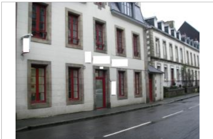
Batiment, 47 rue de Brest - Photographie DHE 2015
