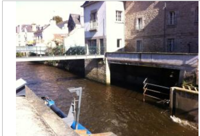
Rue de la Tour d'Auvergne, tablier en rive gauche.
