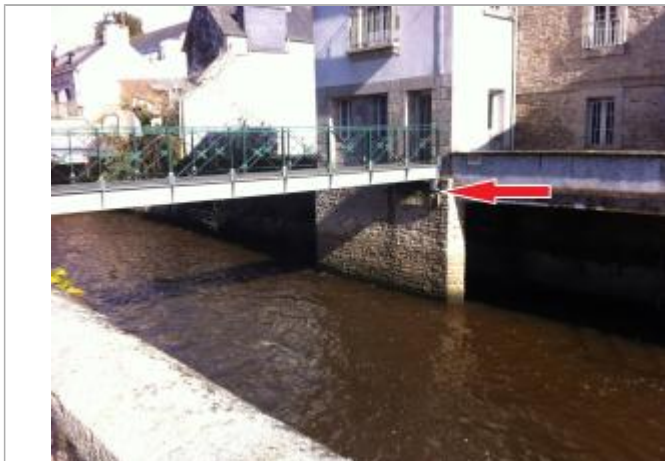
Niveau d'eau déduit à partir d'une photographie par rapport au haut du tablier en rive gauche.
