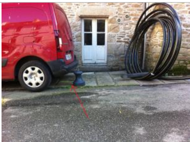
Vue générale du 6 rue de l'Isole
