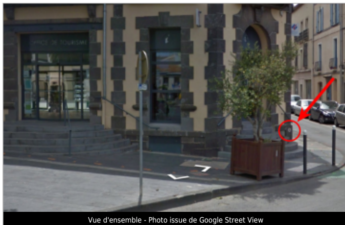
Vue d'ensemble - Photo issue de Google Street View
