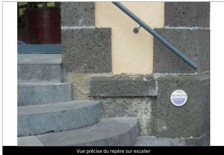
Vue précise du repère sur escalier
