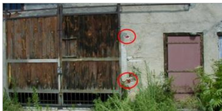
Vue du site - Auteur : CACG
