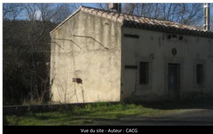
Vue du site - Auteur : CACG
