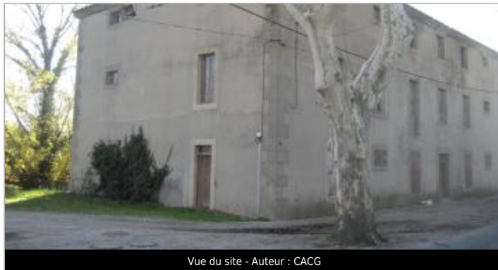
Vue du site - Auteur : CACG
