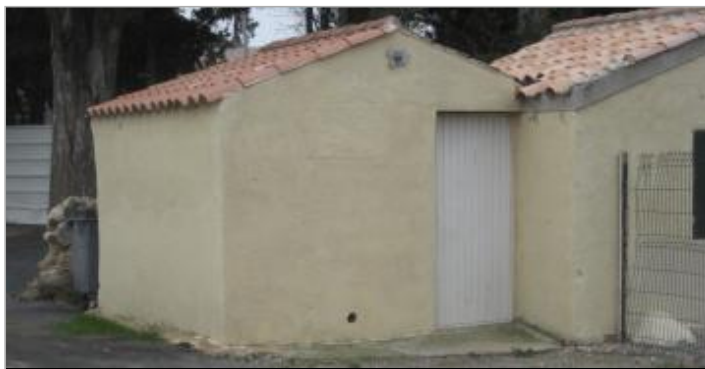
Vue du site - Auteur : CACG
