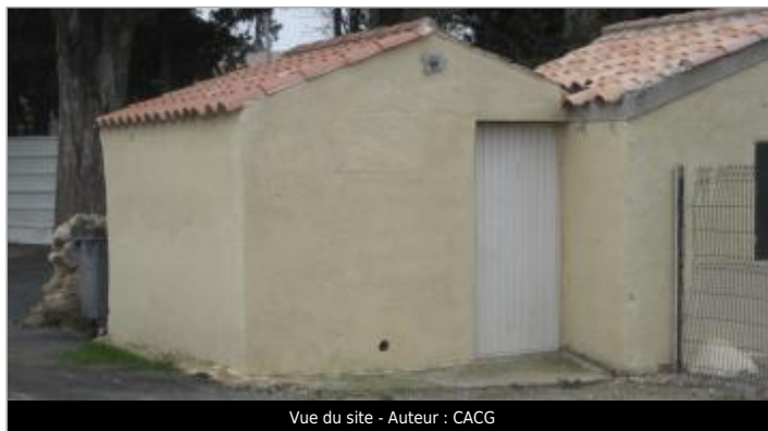
Vue du site - Auteur : CACG
