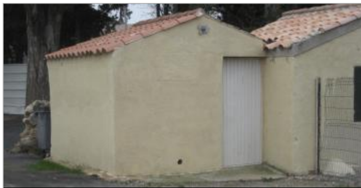
Vue du site - Auteur : CACG
