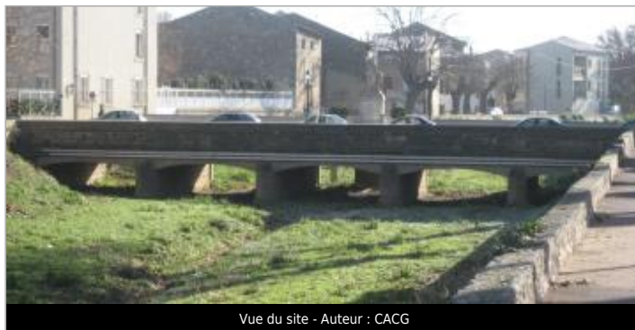
Vue du site - Auteur : CACG
