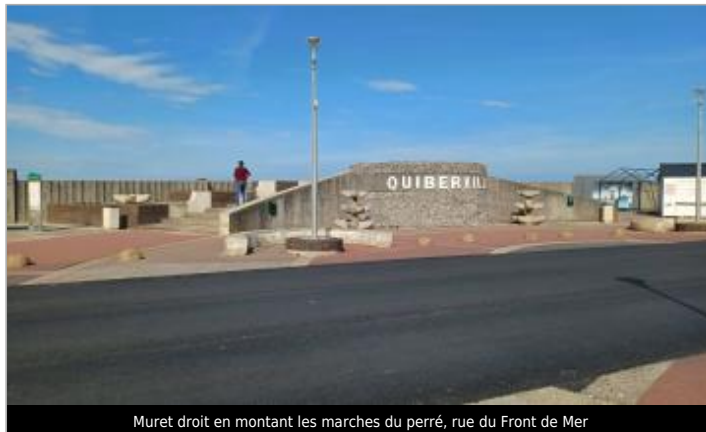
Muret droit en montant les marches du perré, rue du Front de Mer
