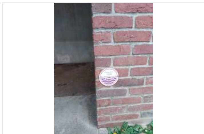
Vue sur le repère normalisé, sur le mur droit de l'ancienne entrée (source : B2HPC SACN)
