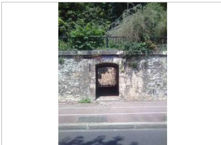
encadrement escalier C face au 168 av Leclerc St Maurice
