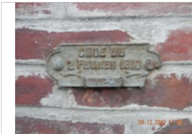
2 rue d'Elbeuf ancienne Mairie témoins crue 1910 - janvier 2010 - auteur photo : Mr Dumarché
