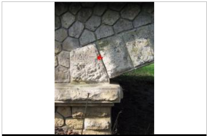
Repère de crue de 1910 - auteur photo : LR de Blois
