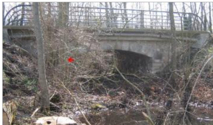
Ouvrage de décharge - auteur photo : LR de Blois
