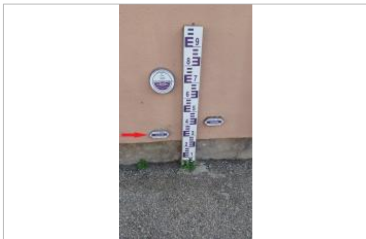
Laisse de crue à 32 cm/sol
