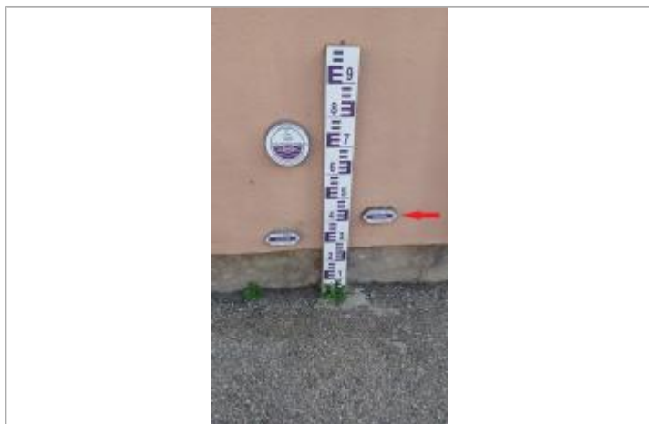
Laisse de crue à 41 cm/sol
