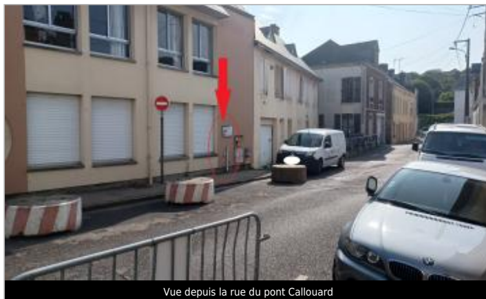
Vue depuis la rue du pont Callouard
