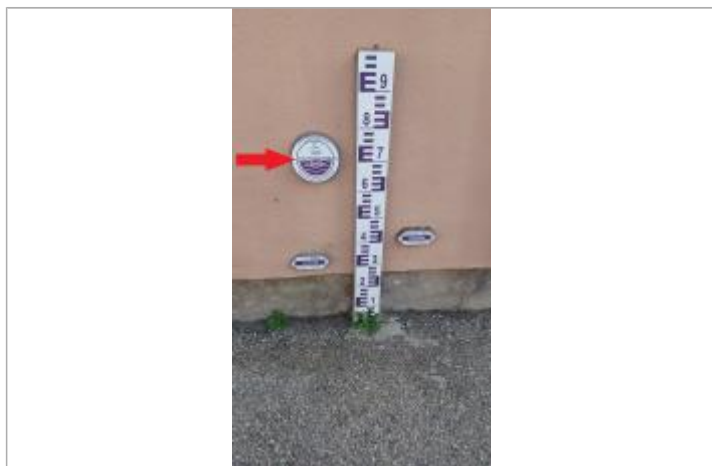
Laisse de crue à 71 cm/sol
