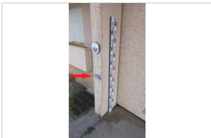
Laisse de crue à 72 cm/sol
