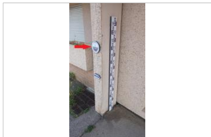
Laisse de crue à 1.15 m/sol
