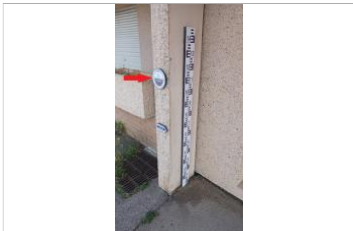
Laisse de crue à 1.15 m/sol
