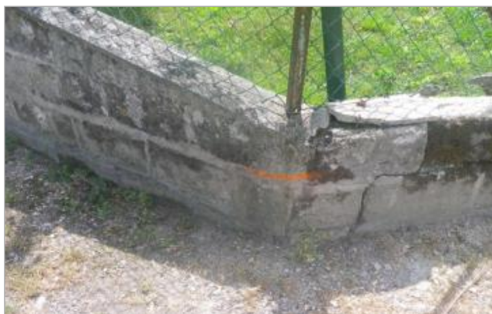
Repère de crue de 1955 - auteur photo : SAFEGE
