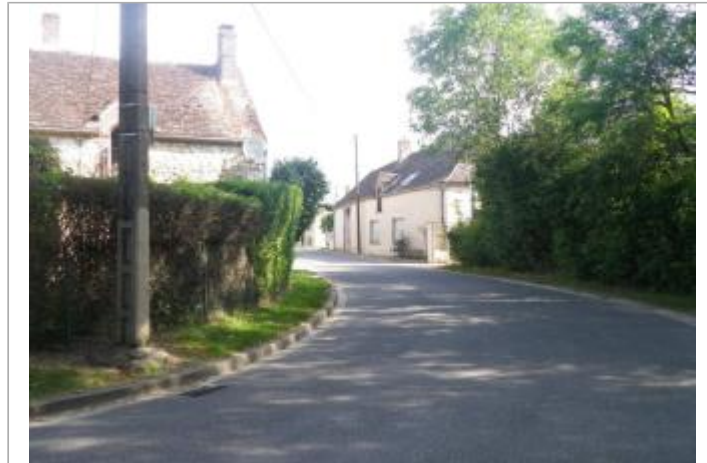
Poteau EDF à la sortie de Toury - auteur photo : SAFEGE
