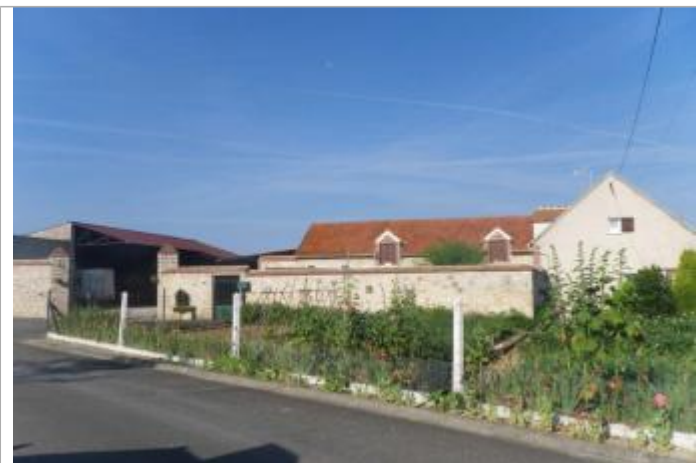
2, rue de la Courterie - auteur photo : SAFEGE
