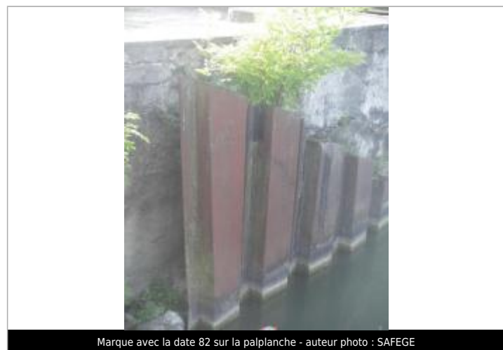
Marque avec la date 82 sur la palplanche - auteur photo : SAFEGE
