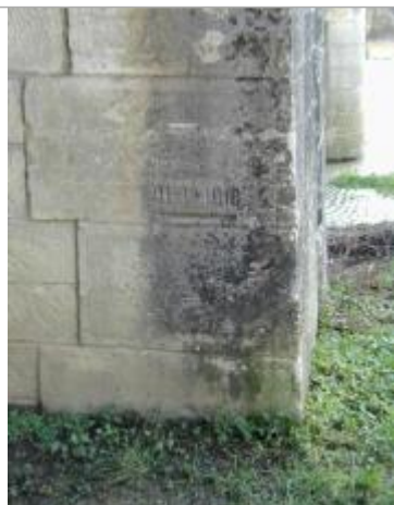
Repère de crue de 1910 - auteur photo : SOGREAH
