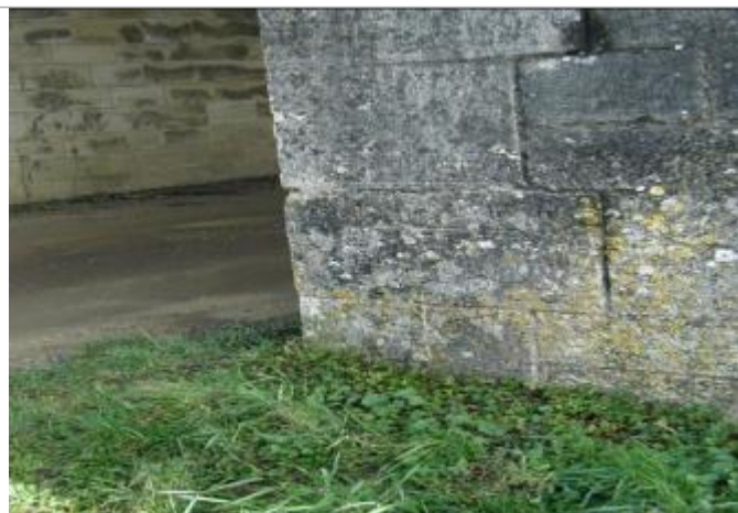
Repères de crue de 1850, 1856 et 1866 - auteur photo : SOGREAH
