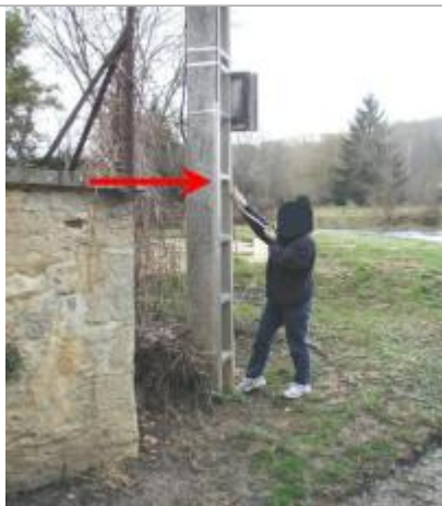
Niveau atteint le 27/04/1998 - auteur photo : SOGREAH
