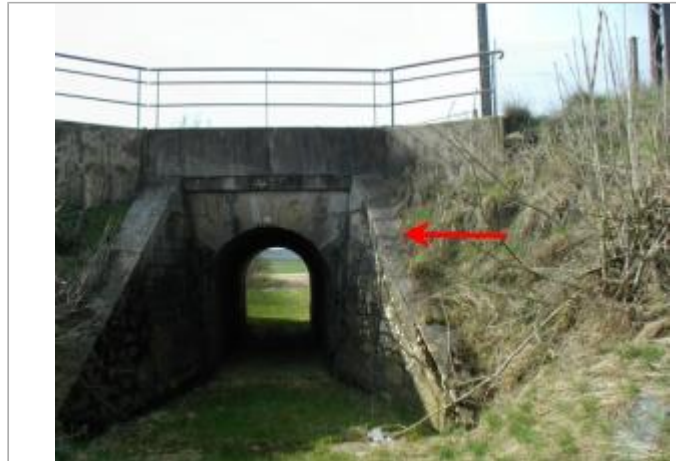
Pont SNCF en contre bas du passage à niveau - auteur photo : SOGREAH
