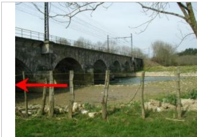
Pont SNCF sur l'Armançon - auteur photo : SOGREAH
