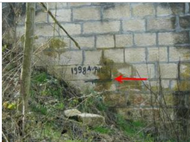
Repère de crue de 1998 - auteur photo : SOGREAH
