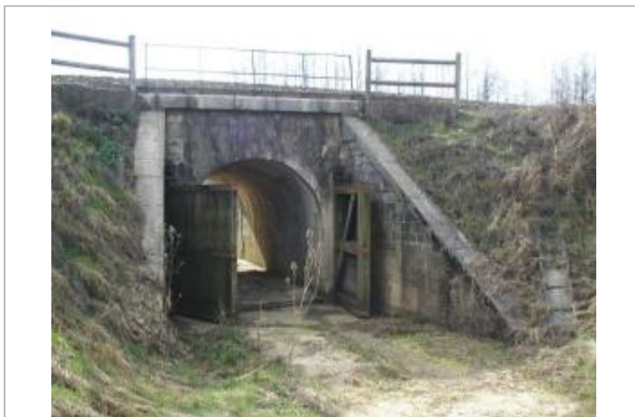
Pont SNCF - auteur photo : SOGREAH
