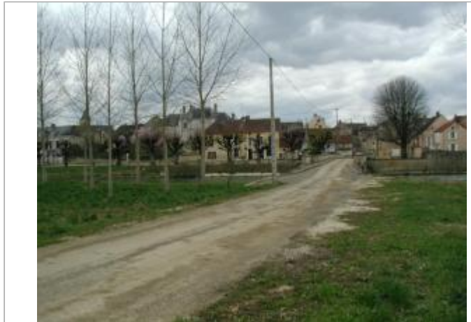
Route d'accès à Argentenay - auteur photo : SOGREAH
