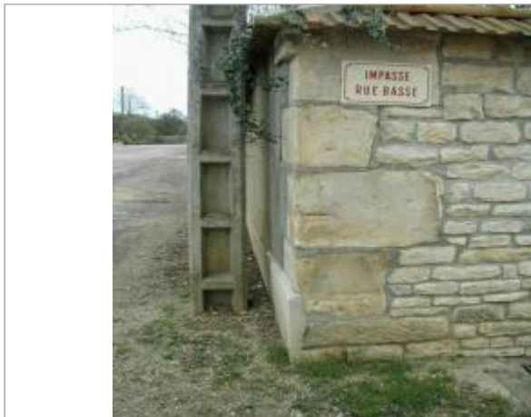
Angle de la rue Basse et de l'impasse du même nom - auteur photo : SOGREAH
