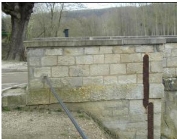
Repère de crue de 1910 - auteur photo : SOGREAH
