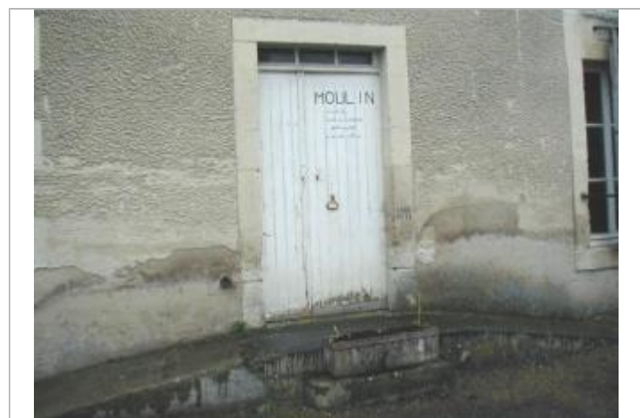
Niveau d'eau atteint le 27 avril 1998 (sommet de la dernière marche) - auteur photo : SOGREAH
