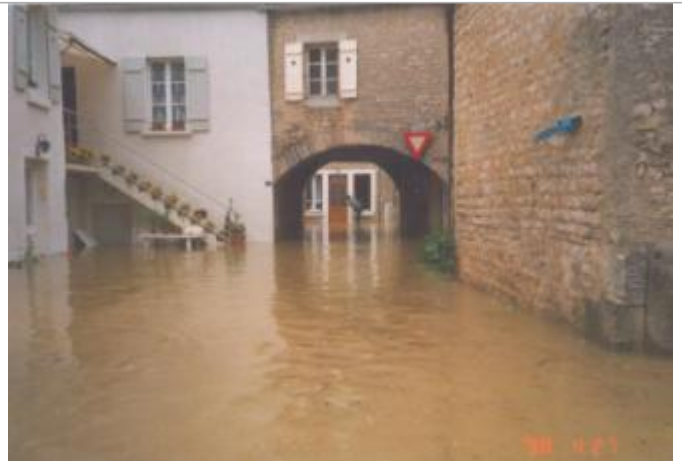
Porche donnant sur la rue Marthe Saillard lors de la crue de 1998 - auteur photo : ?
