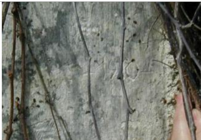
Repère de crue de 1910 - auteur photo : SOGREAH
