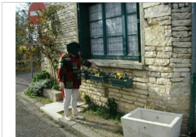
Repère de crue de 1998 - auteur photo : SOGREAH
