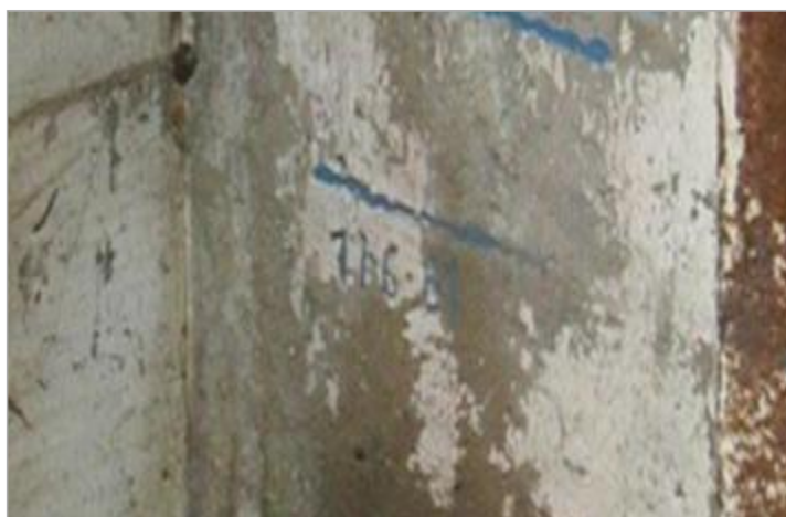
Repère de crue de 1981 - auteur photo : SOGREAH
