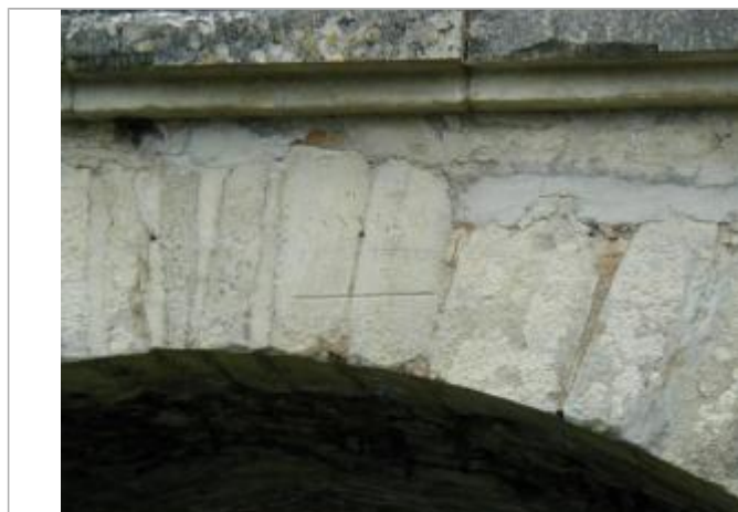
Repère de crue de 1910 - auteur photo : SOGREAH
