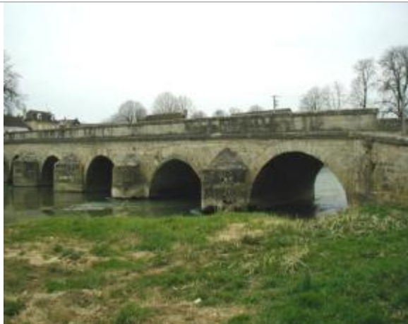
Pont de Pacy sur Armançon - auteur photo : SOGREAH
