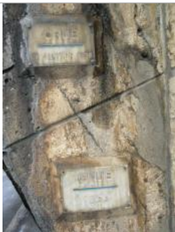
Repères de crue de 1910 et 1955 - auteur photo : DIREN IDF
