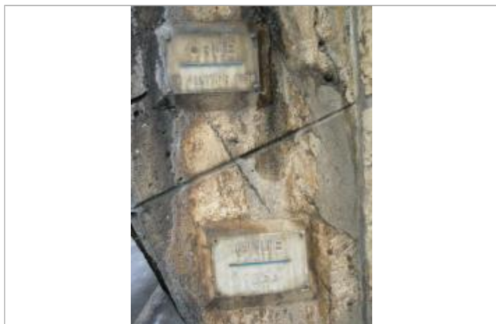
Repères de crue de 1910 et 1955 - auteur photo : DIREN IDF
