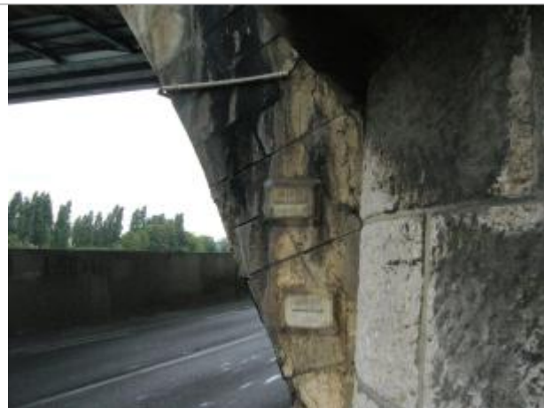
Pont SNCF (RER) - auteur photo : DIREN IDF
