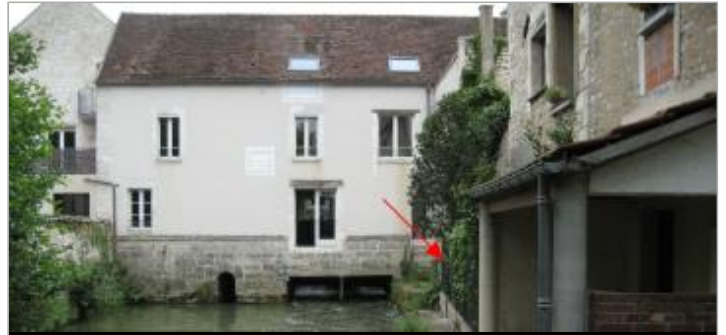
Vue aval du \"Vieux Moulin\" - auteur photo : CACG
