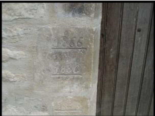
Les quatre repères de crues de la façade - auteur photo : CACG
