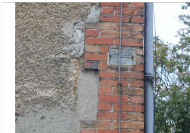
Repère de crue de janvier 1910 - auteur photo : DIREN IDF
