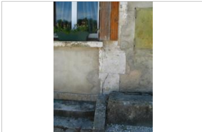
Maison éclusière de Belombre, n°76 - auteur photo : DIREN IDF
