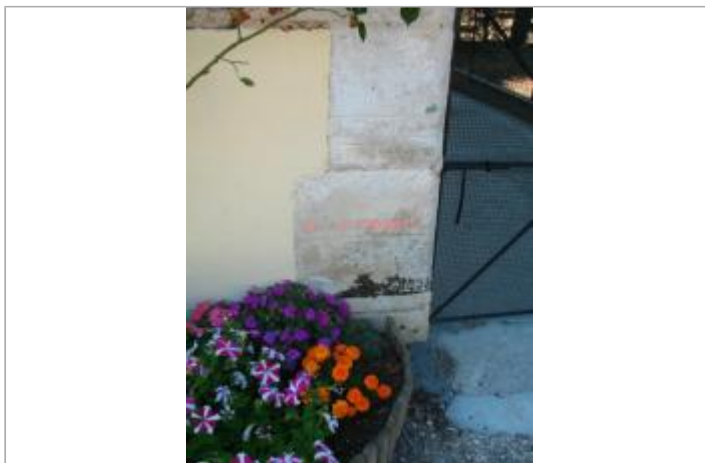
Maison éclusière de Vaux, n°78 - auteur photo : DIREN IDF
